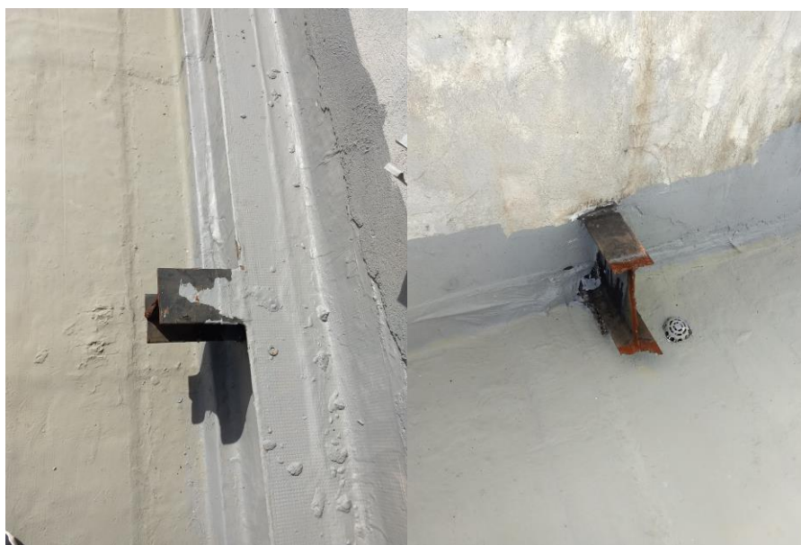
Perfis metálicos que devem ser removidos
