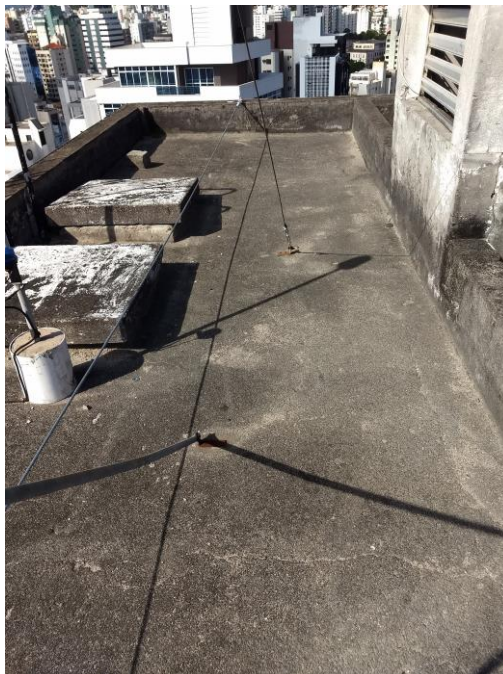
Tampas de acesso ao reservatório que serão substituídas
