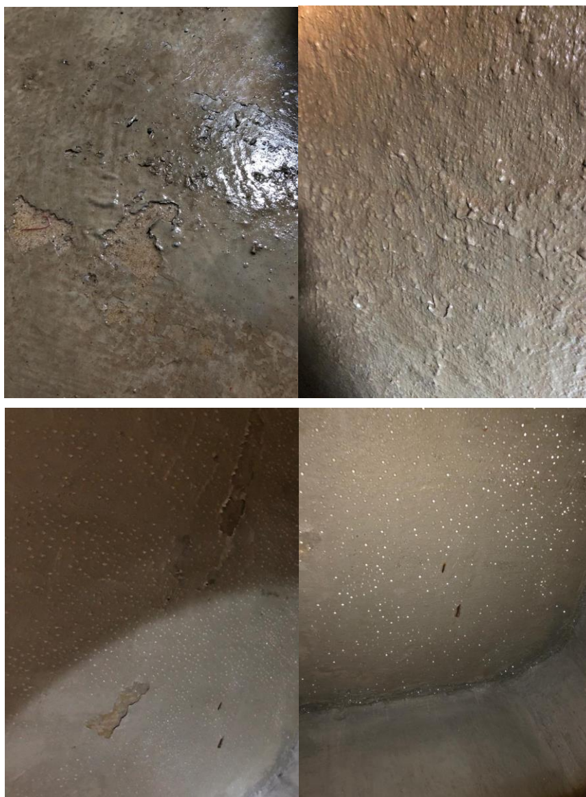
Membrana acrílica que será removida
