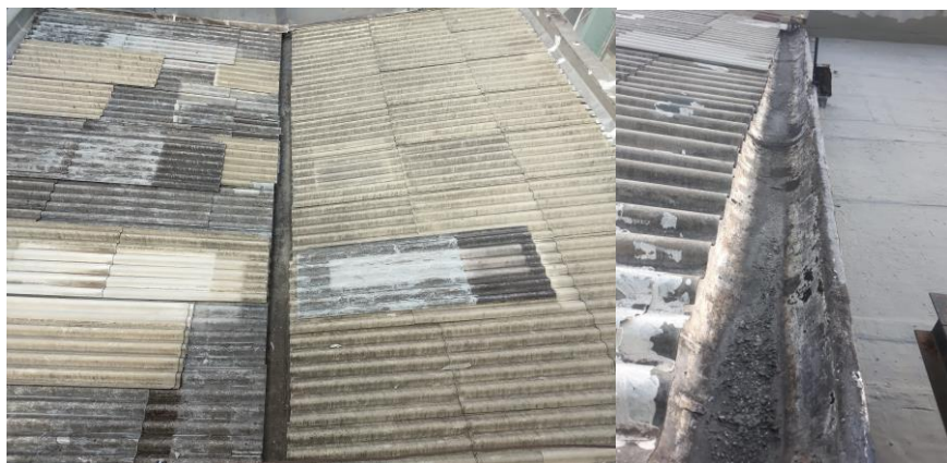
Calhas que terão a impermeabilização removida
